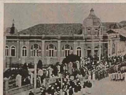
Fig. 3. Inauguração do Edifício em 1934. Fonte: Etec-Laguna Iphan-SC
